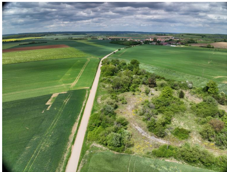
Projet de centrale PV à Saint-Martin-Lès-Langres
