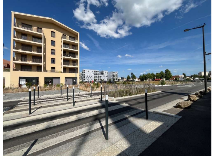
Vue sur le site depuis Avenue de la Grande Halle, Lot G3 Visite de site, Juin 2025
