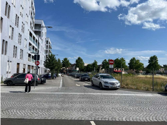
Vue de Rue Charles Péguy Visite de site, Juin 2025
