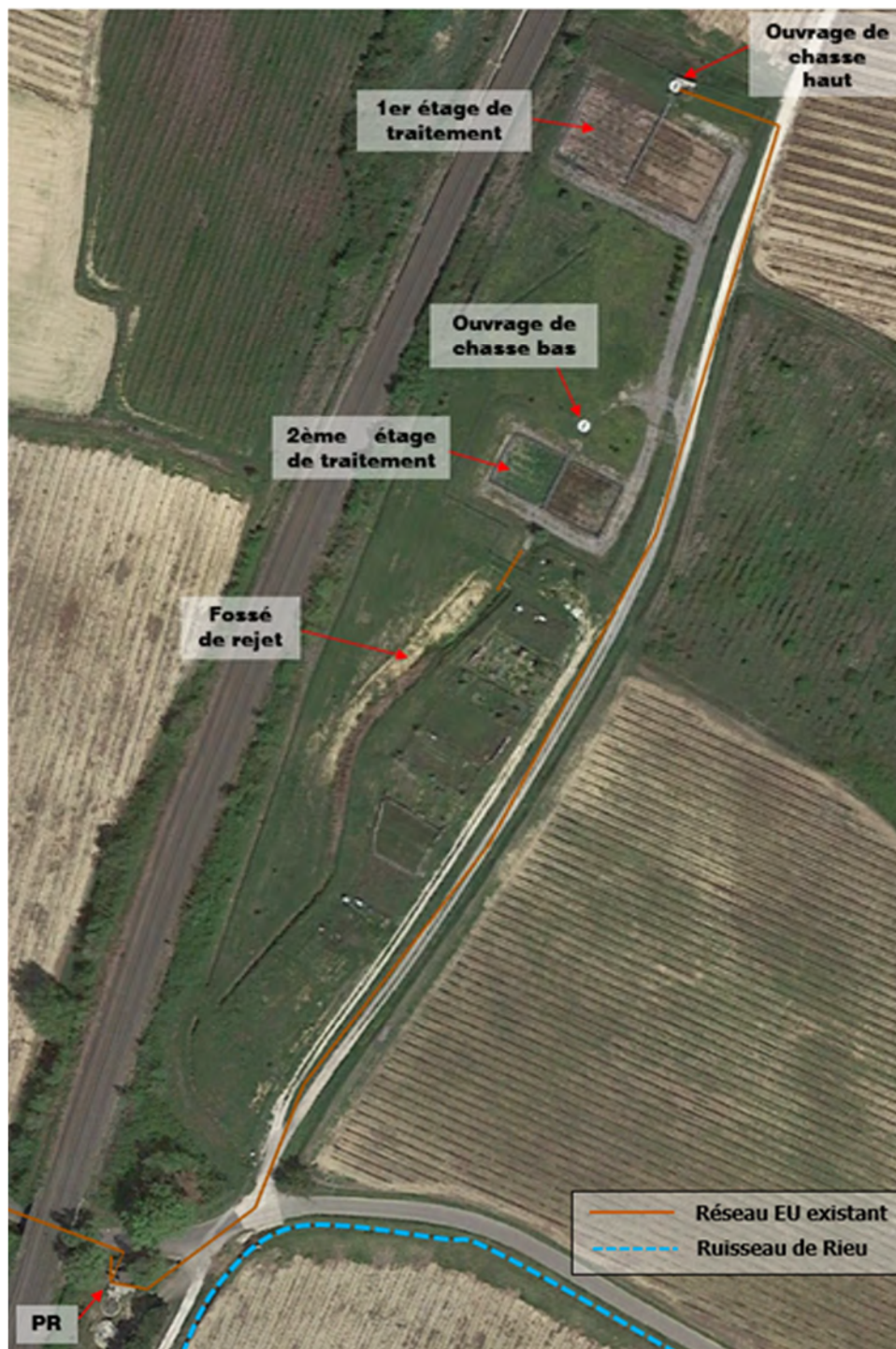
Figure 5 : Vue aérienne et fonctionnement de la STEU de Montignargues (Cabinet Merlin)
