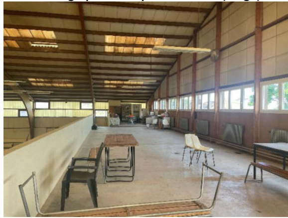
Figure 3 : Photographies de l'état actuel du site (juin 2025)
