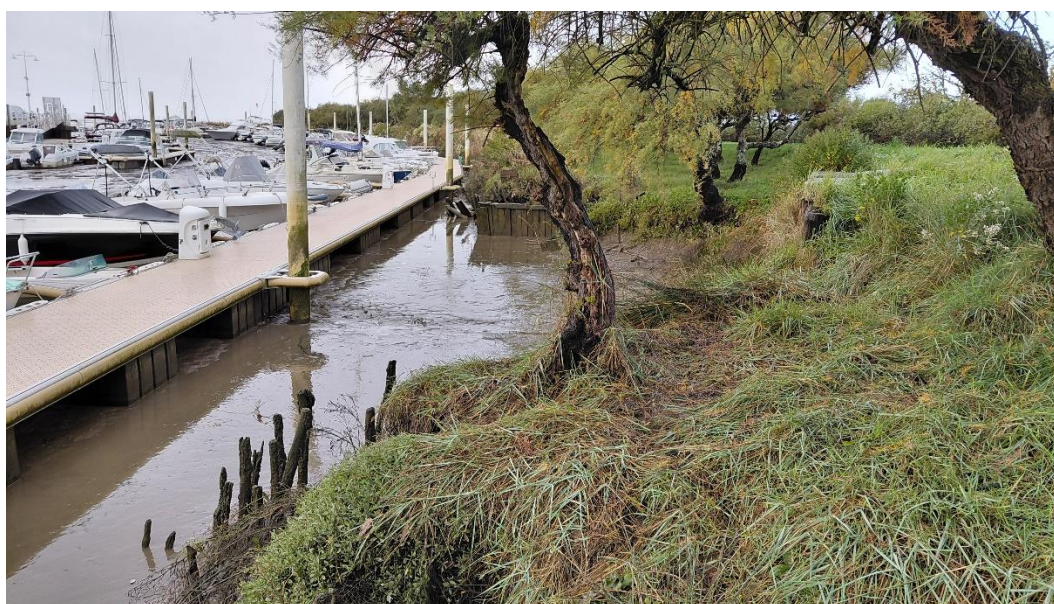
Figure 5 Vestiges d'anciennes protections de berges
