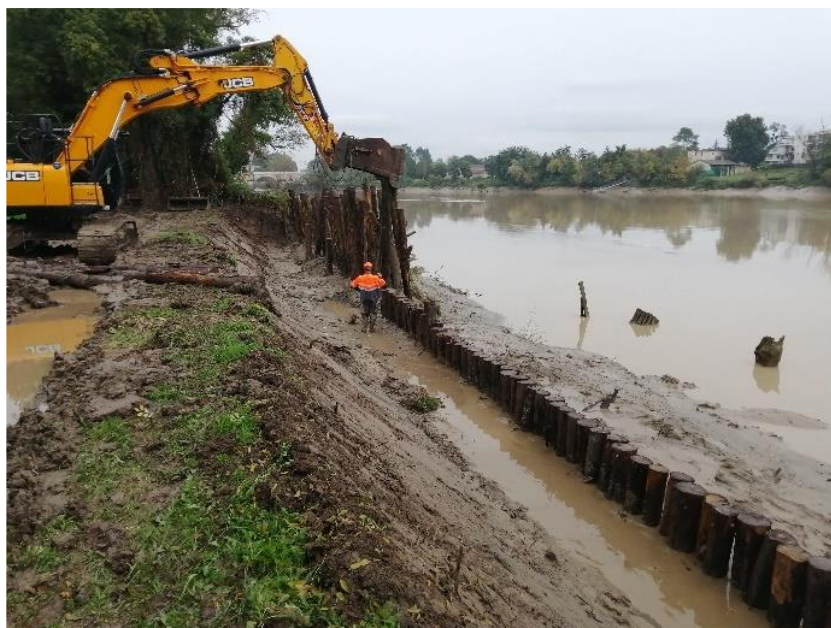
Figure 13 Rideau jointif de pieux bois en cours de mise en œuvre
