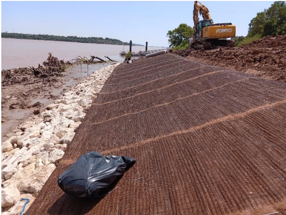
Figure 15 Protection du talus de berge après retalutage
