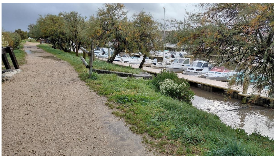
Figure 1 Erosion forte des berges du port d'Audenge
