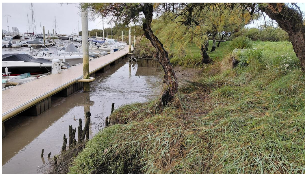
Figure 2 Vestiges d'anciennes protections de berges
