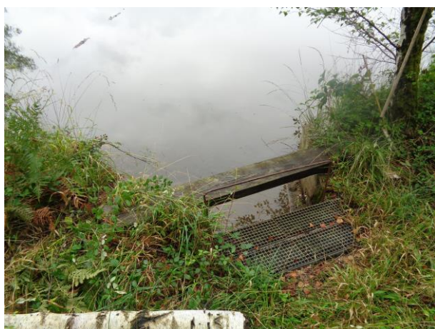
Vue du seuil de surverse
