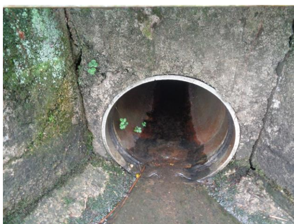
Vue du collecteur Ø 400 en aval de la surverse
