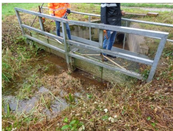
Vue du seuil de surverse
