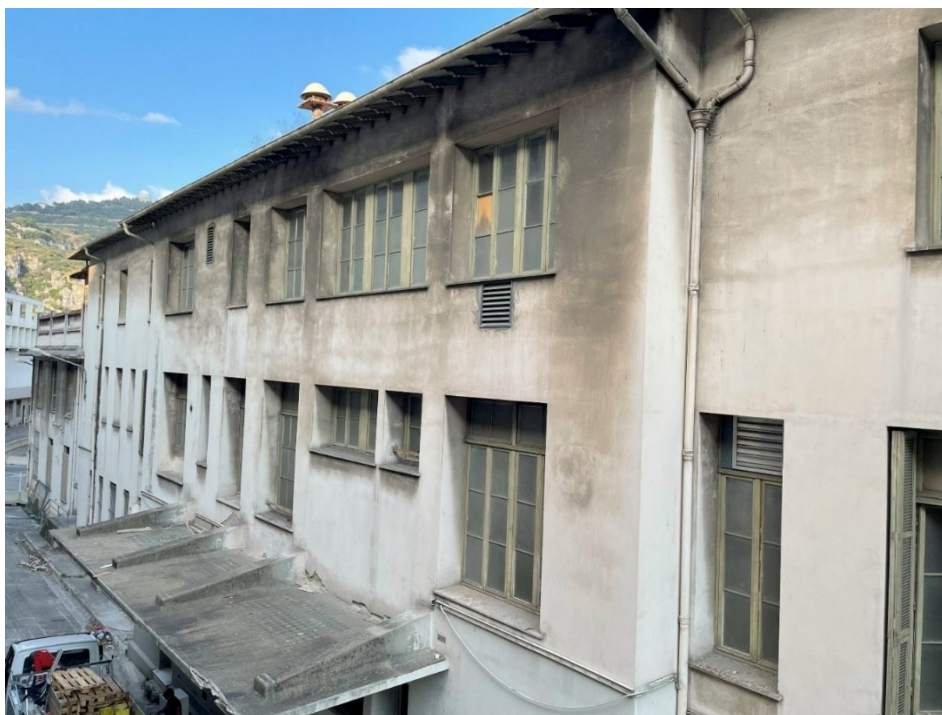
Figure 21. Façade nord présentant des éléments propices à l'installation d'oiseaux
