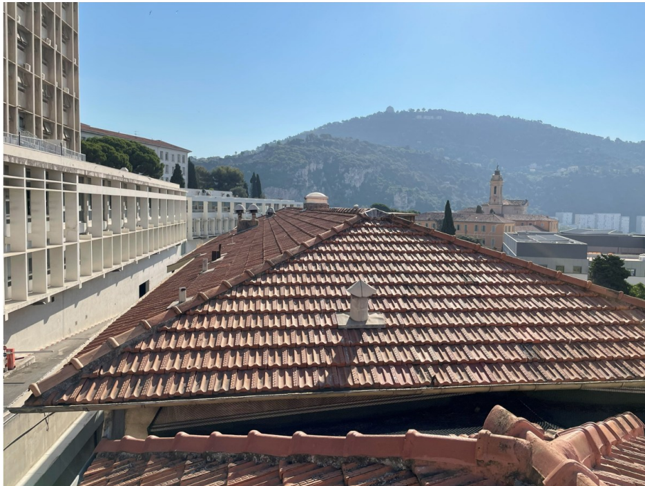
Figure 19. Toiture en tuiles
