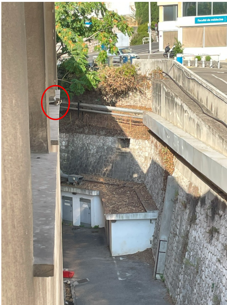
Figure 24. Hirondelles de rocher posées sur un rebord de fenêtre du bâtiment
