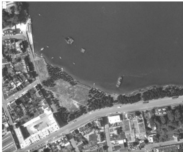
Vue aérienne du site de 1966 au niveau de l'exutoire
