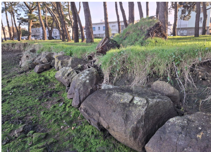
Vue du trait de côte au niveau du futur exutoire
