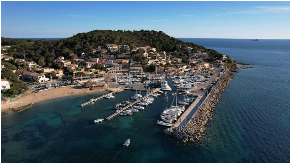
PHOTOGRAPHIES AERIENNES AUTOUR DU PORT
