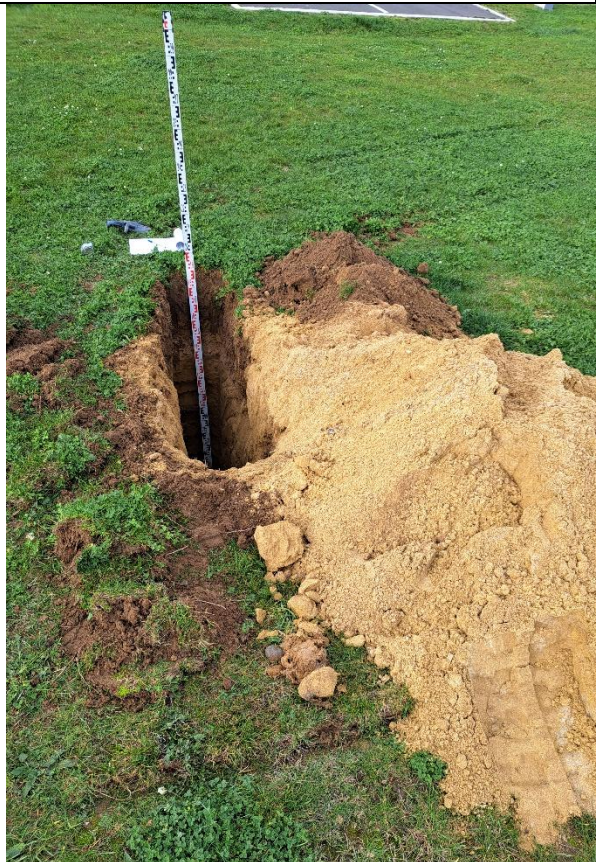
Tranchée réalisée à 2 m de profondeur au droit du site
