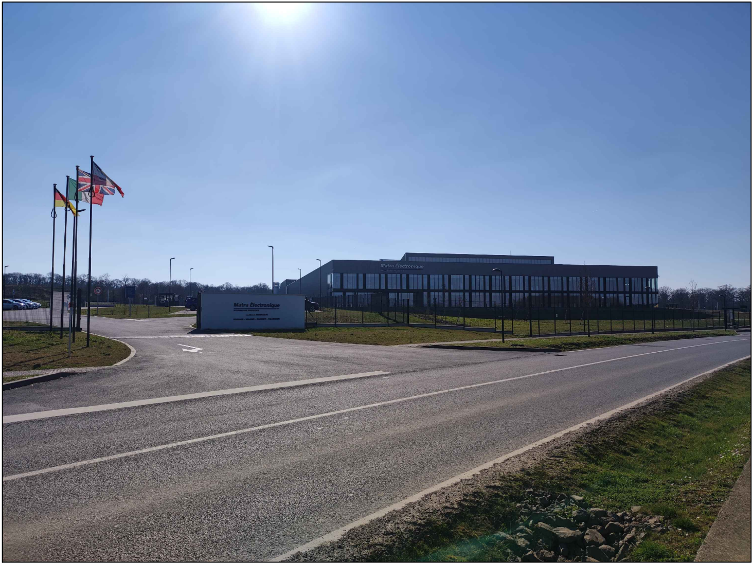
PHOTO N°1 - ENVIRONNEMENT PROCHE - PRISE LE 18/03/2025
