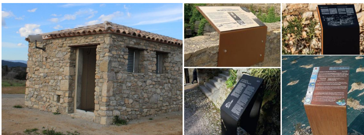
Figure 24 : Poste de transformation avec bardage en pierre locale et panneaux pédagogiques d'information (Source : Sun'Agri, novembre 2024)
