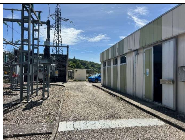
Photographie 6 : Bâtiment de commande
