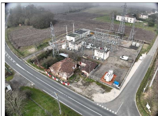
Photographie 1 : Vue aérienne du PS de BRUCH
