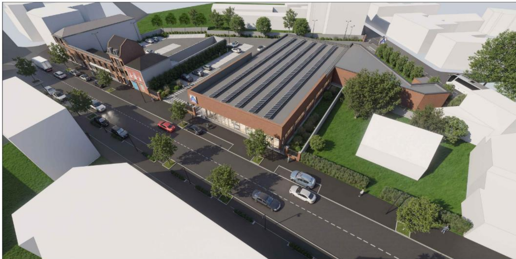
Figure 8 : Insertion du projet dans son environnement
