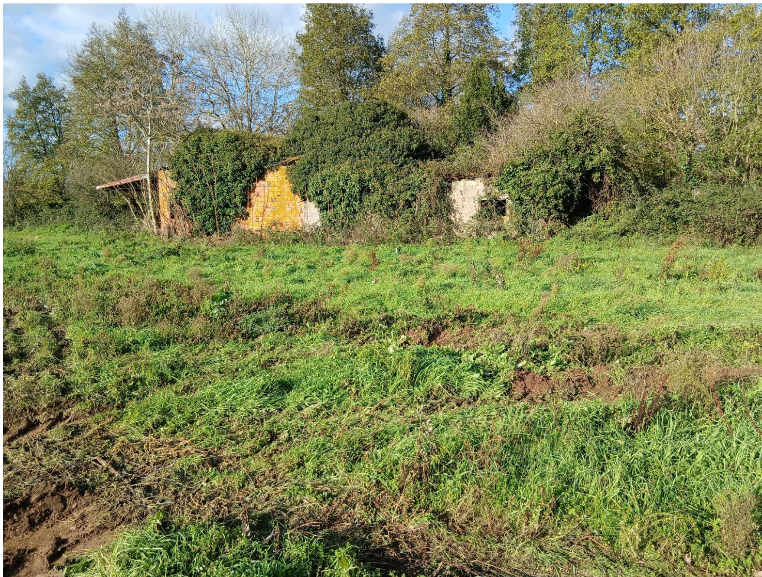
Bâtiment à détruire – plus de toiture
