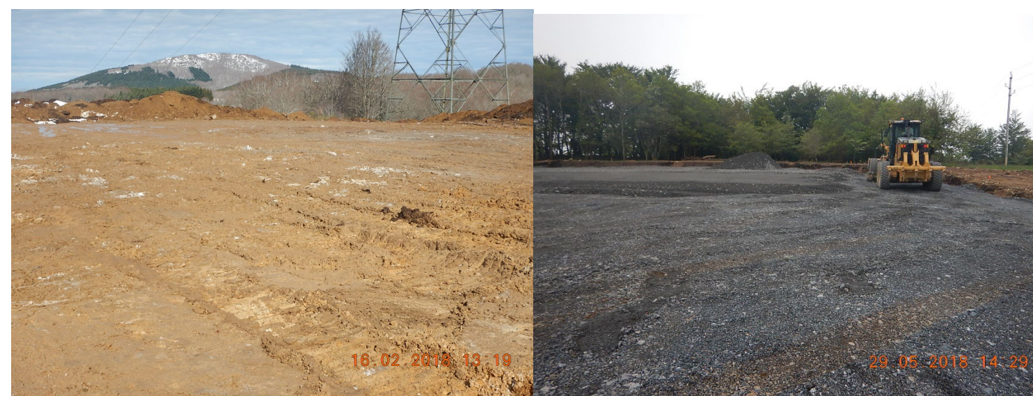
Terrassement de la parcelle/Gravillonnage de la plateforme HTB
