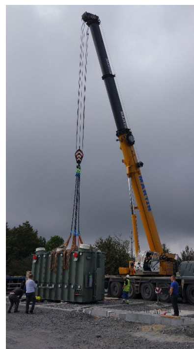
Pose du transformateur de puissance
