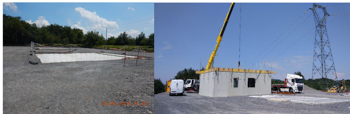
Fondation du bâtiment technique/Construction du bâtiment
