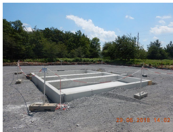
Création des fondations des transformateurs
