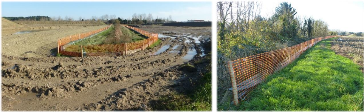
Figure 6 : Exemples de balisages de zones sensibles en phase chantier
