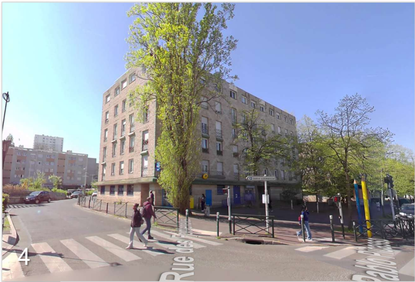
Vue sur une barre de logements sise 102 avenue P. Picasso avec les locaux de la Poste de NANTERRE à rez-de-chaussée
