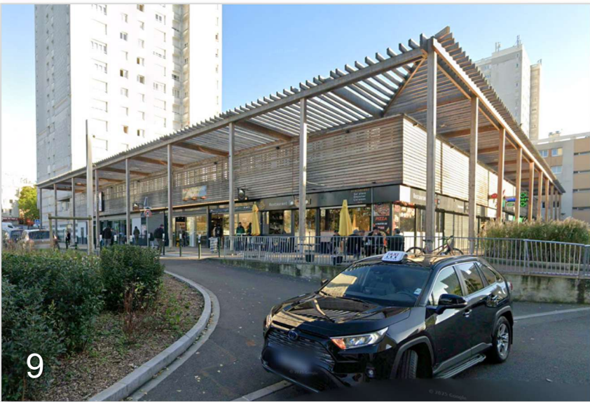
Vue sur le Centre Commercial des Fontenelles rénové
