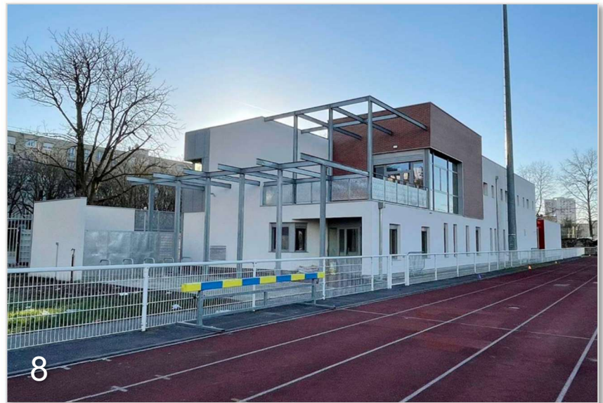
Vue sur les nouveaux locaux des vestiaires du Stade Guimier livrés en 2021
