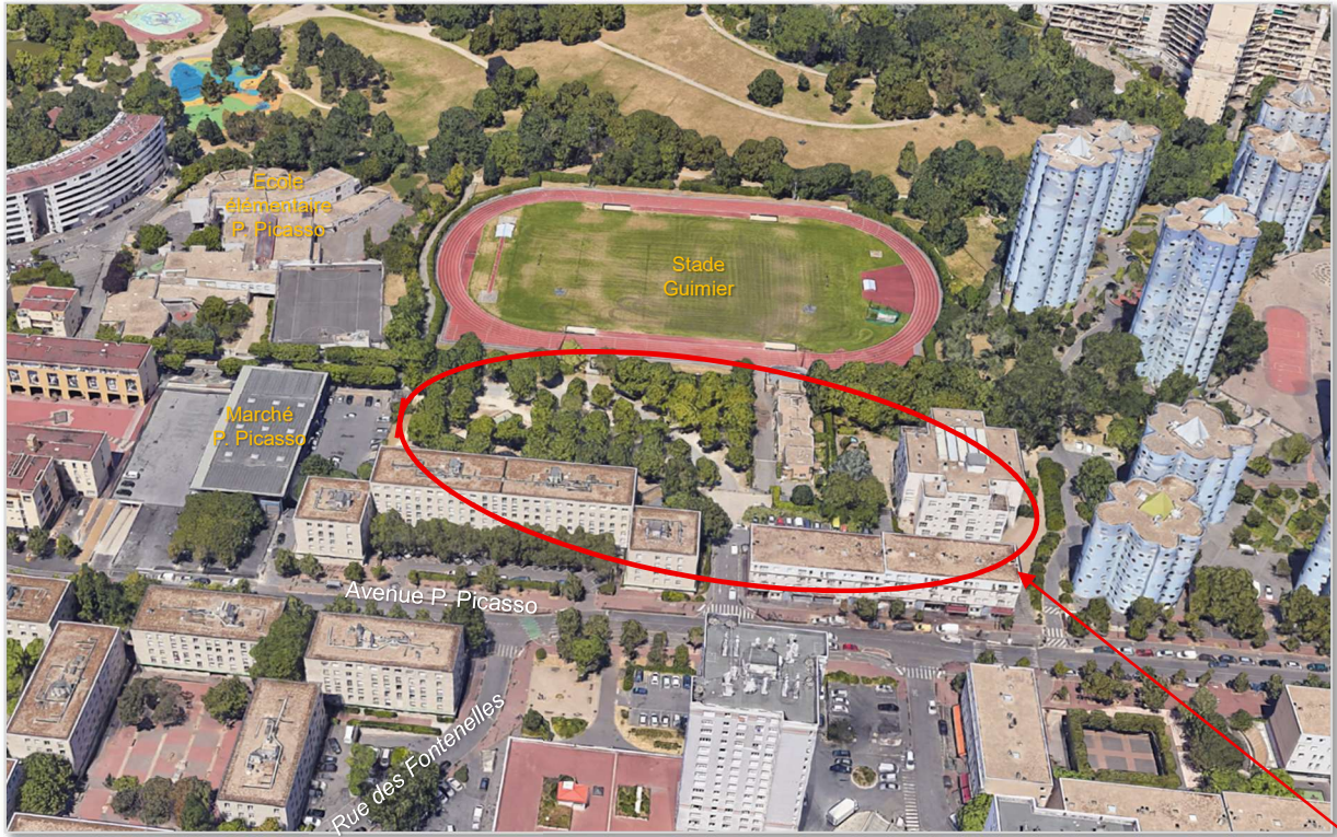
Vue en direction du Nord
