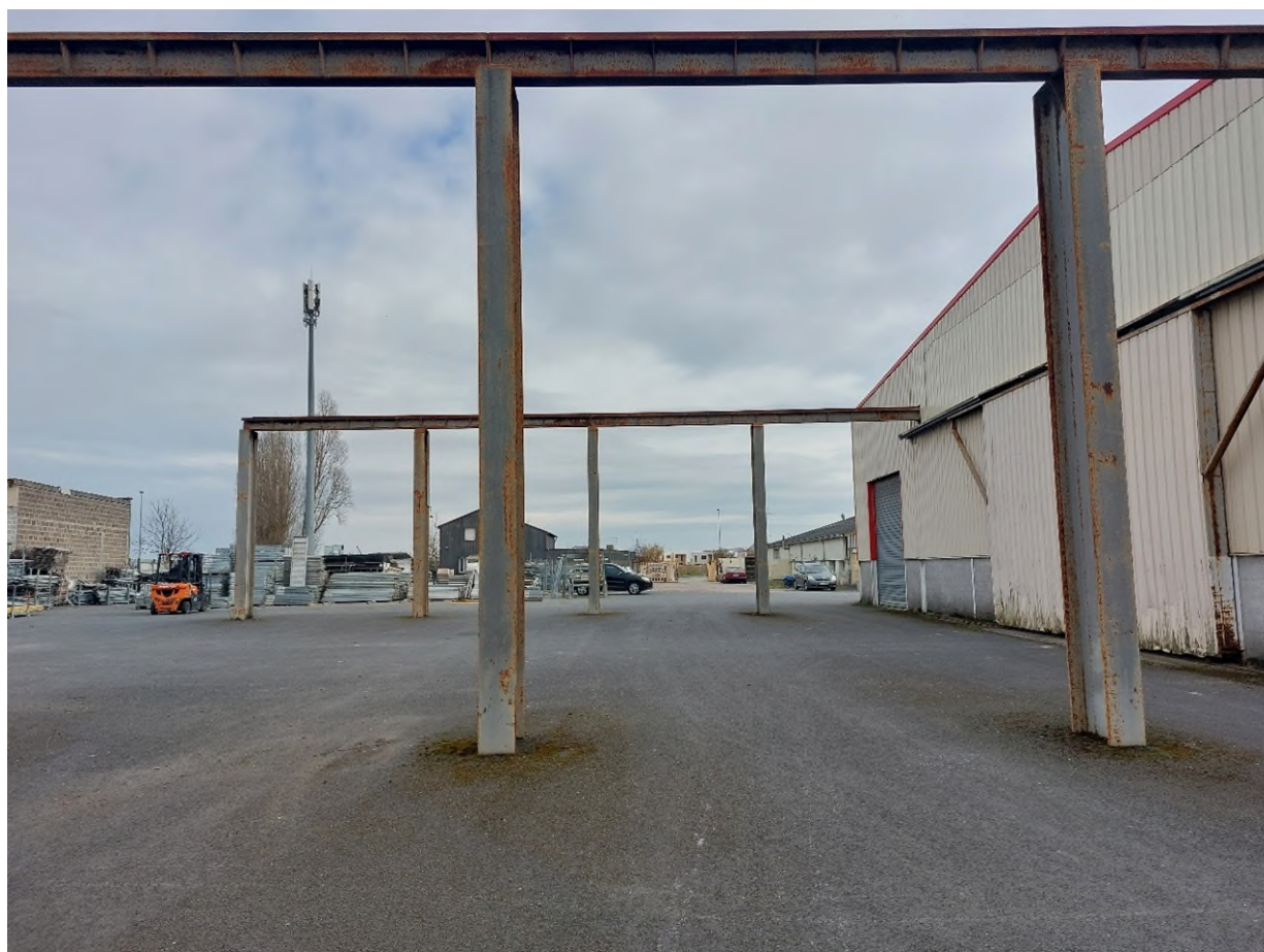
Figure 19 – Photographie du portique existant sur la parcelle AN43
