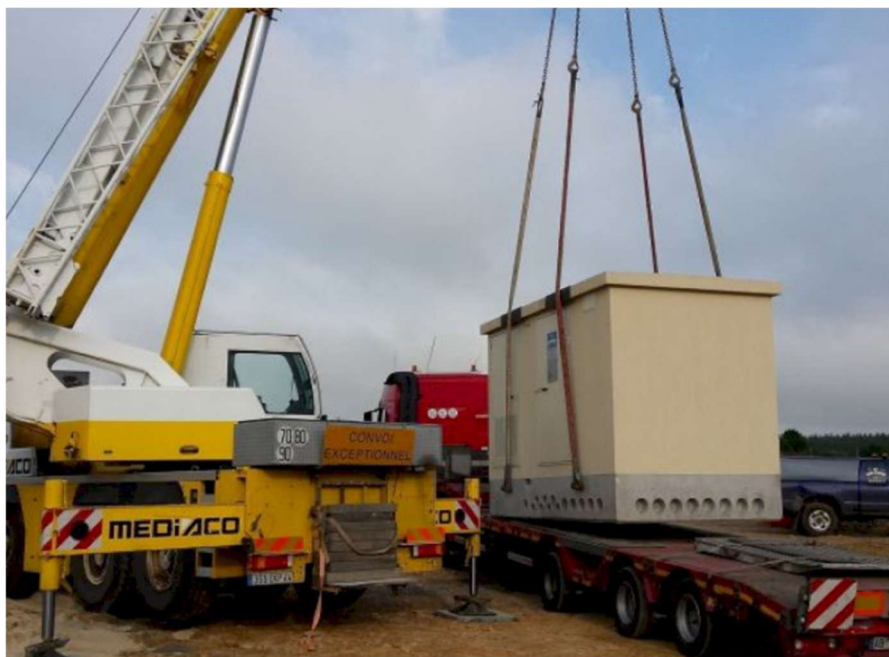
Figure 34 Grutage du préfabriqué
