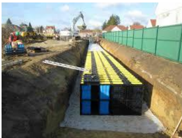
Structure réservoir alvéolaire
