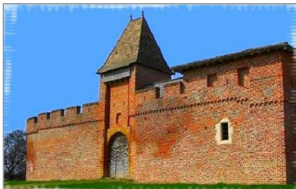
Maison forte de Villon
