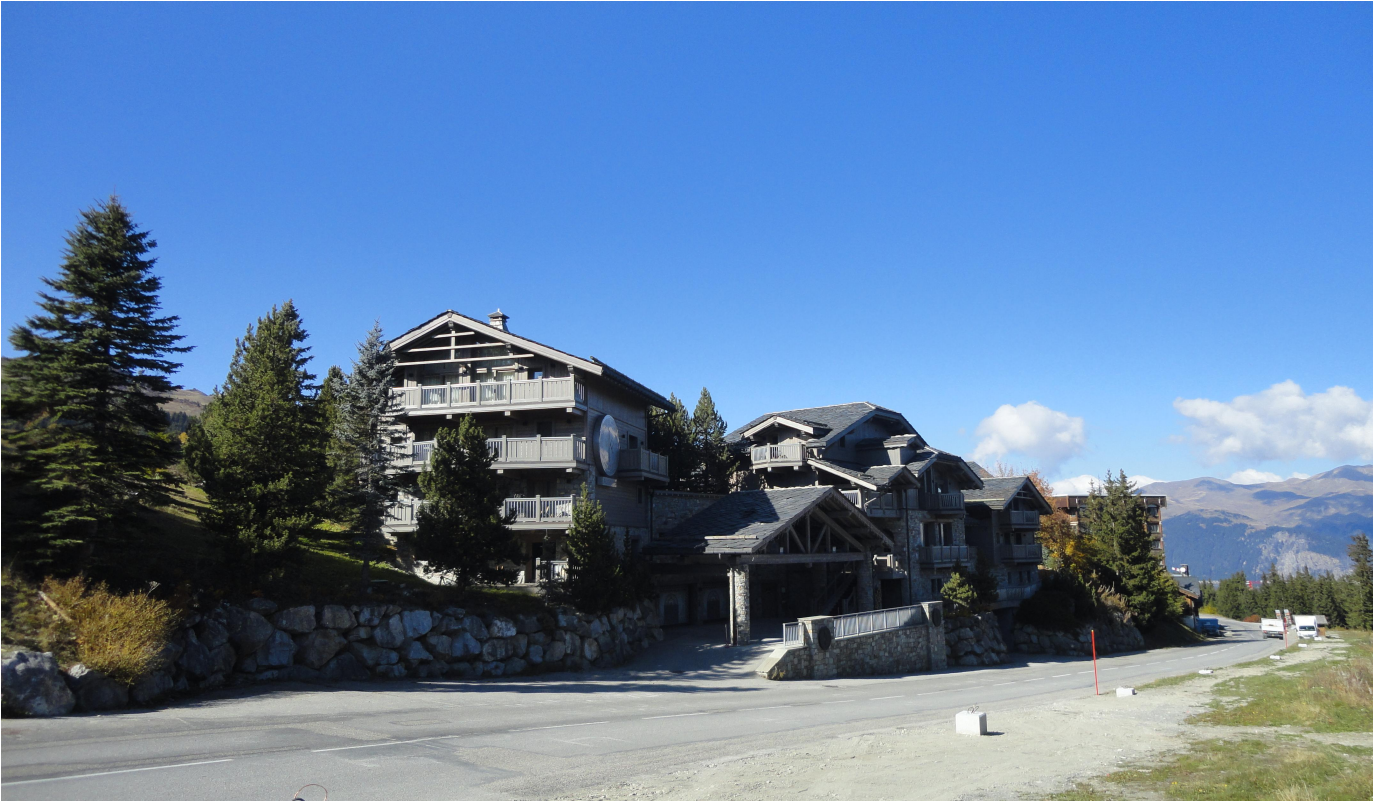
Existant à démolir / Eté
