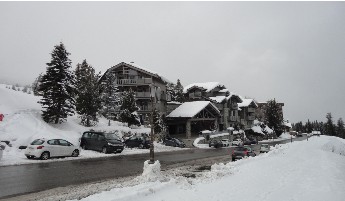
Existant à démolir / Hiver
