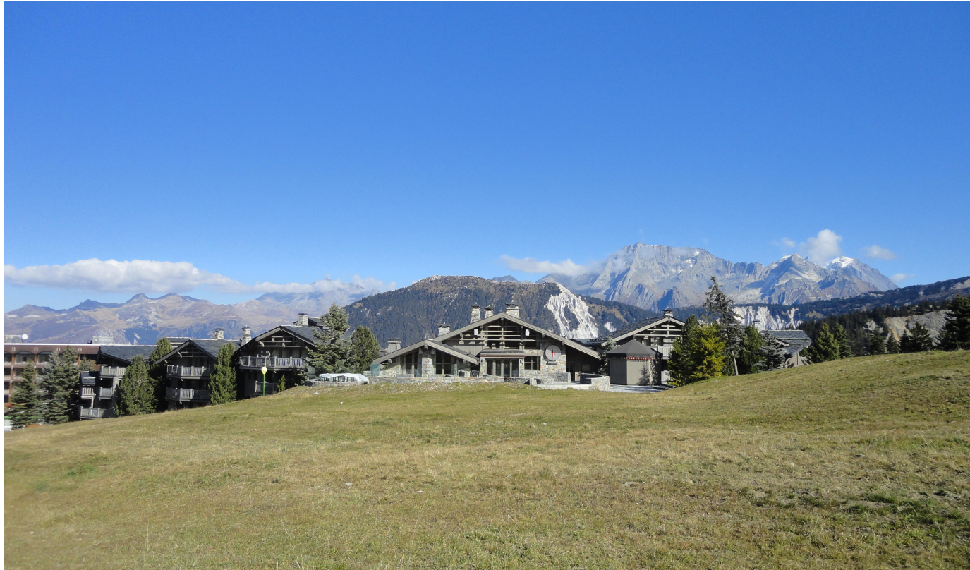
Existant à démolir / Eté
