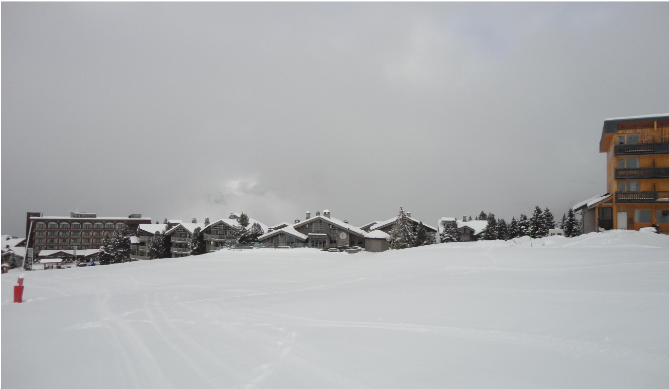
Existant à démolir / Hiver
