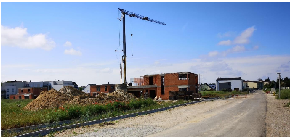
Quartier d'habitation en construction
