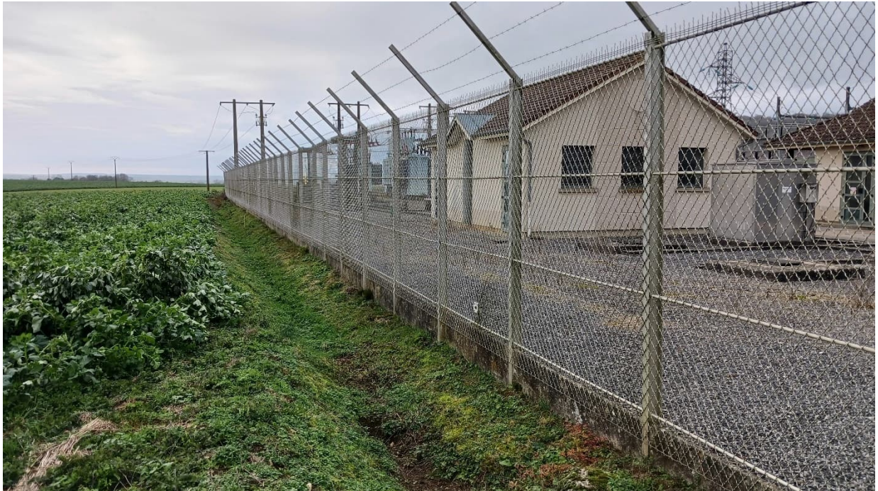
Figure 7 : Clôture sud-est du poste et champ cultivé adjacent – vue du coin est, NEGE, novembre 2025
