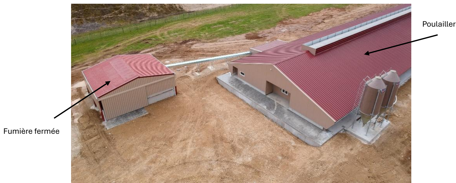
Image prise sur le site de BFC construction – constructeur français -
