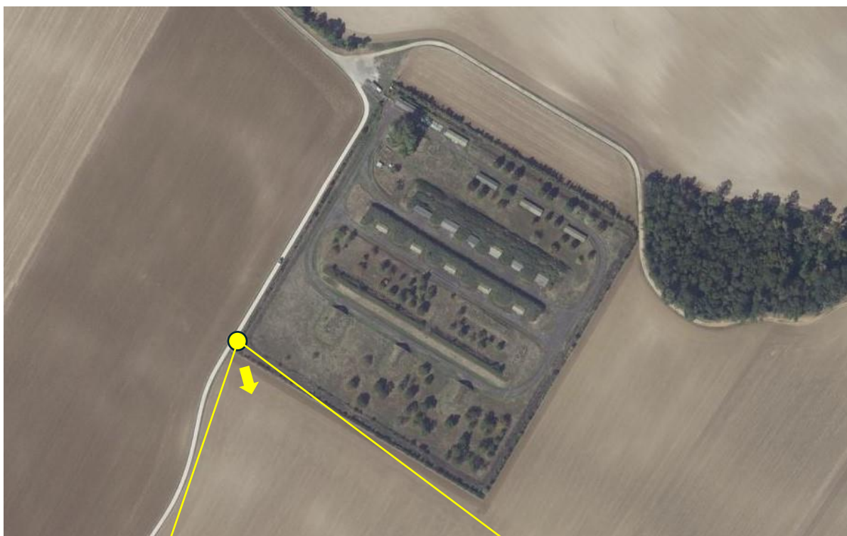
Vue du site sur le côté Sud-Ouest et de son environnement en direction du Sud-Sud-Est
