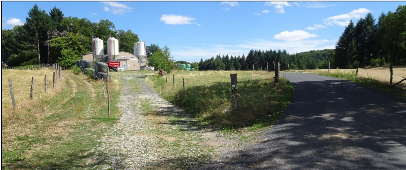
Figure 28 : Photographie d'un bâtiment agricole (Crédit photo : NCA Environnement)
