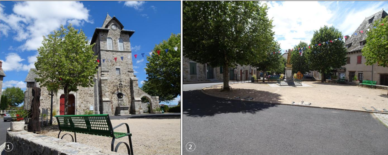
Figure 21 : Prise de vue 1 - Photographie du Pont Rompu / Prise de vue 2 - Photographie du paysage visible depuis ses abords en direction du site d'étude (Crédit photo : NCA Environnement)
