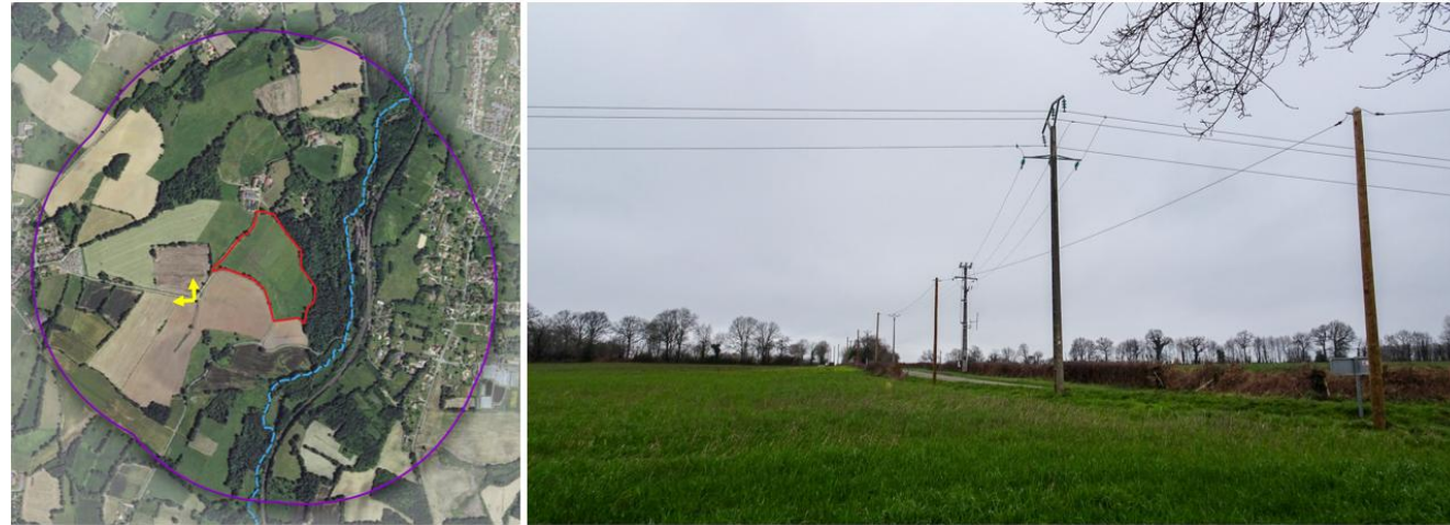
Figure 43 : Photographie mettant en avant le passage de lignes électriques locales (Crédit photo : NCA Environnement)
