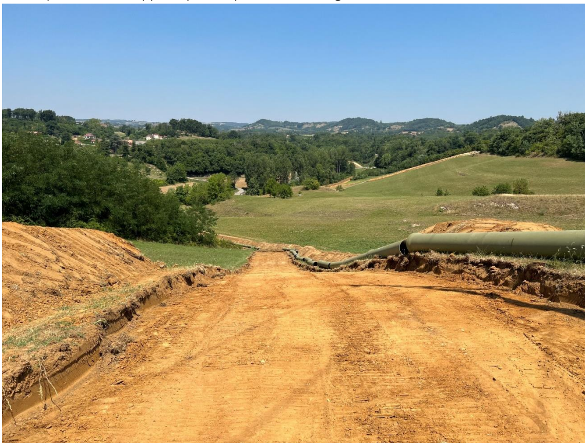
Décapage de la terre végétale sur un projet précédent
