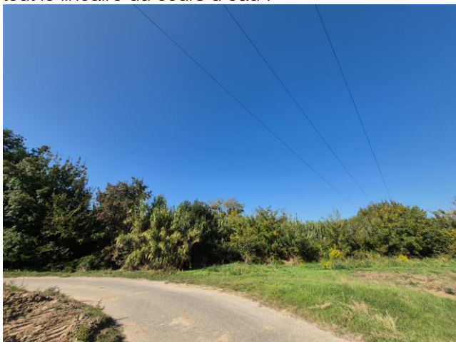
Photo prise depuis le sud du cours d'eau en direction du passage sélectionné
