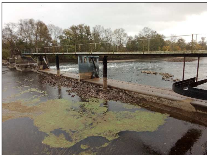
Photo 1 : Vue des clapets rive droite
