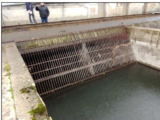
Photo 3 : Vue des grilles de l'usine existante
