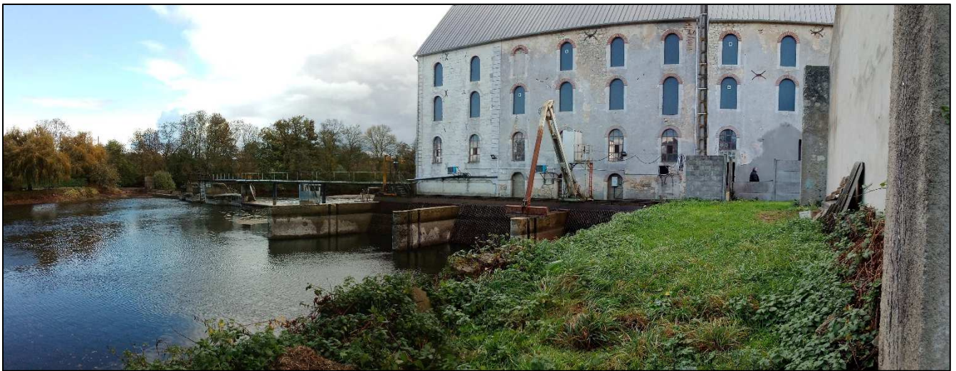
Photo 13 : Vue amont de l'usine existante
