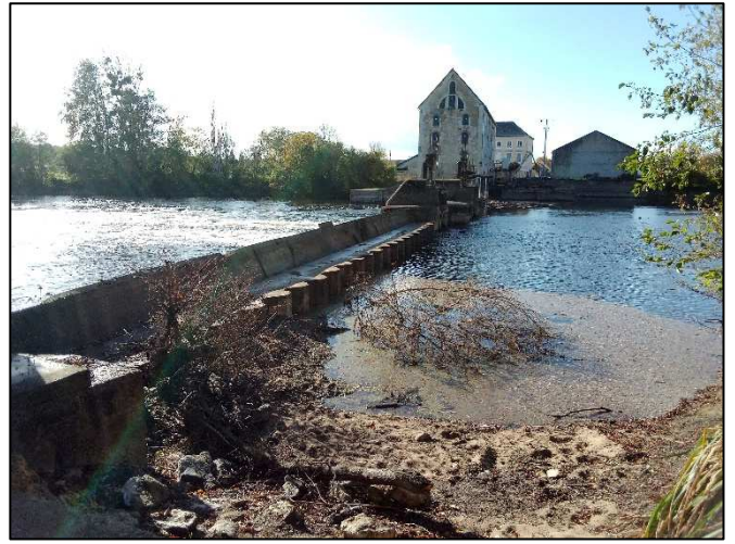
Photo 6 : Vue amont du clapet rive gauche
