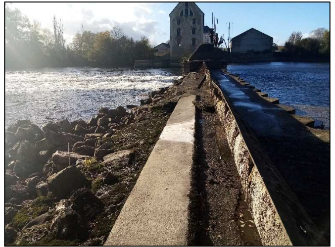
Photo 8 : Vue aval du clapet rive gauche
