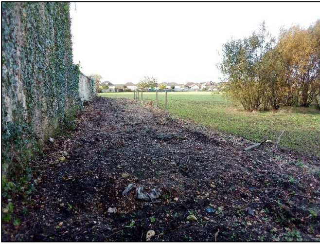
Photo 11 : Accès des engins par le pré pour les travaux rive droite
