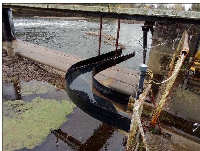
Photo 4 : Canal de dégrillageage existant
