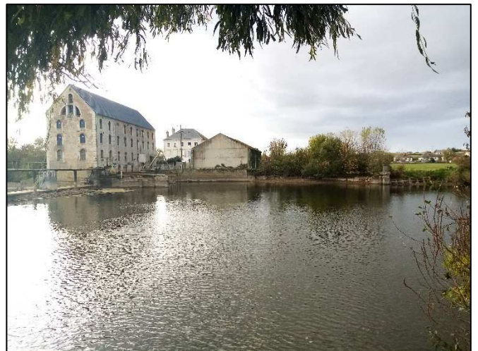
Photo 10 : Vue de la centrale existante de la berge amont rive droite
