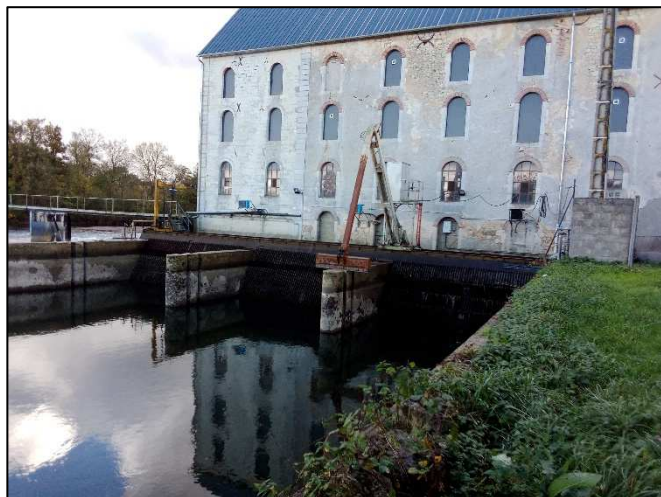
Photo 2 : Vue de la prise d'eau rive droite
