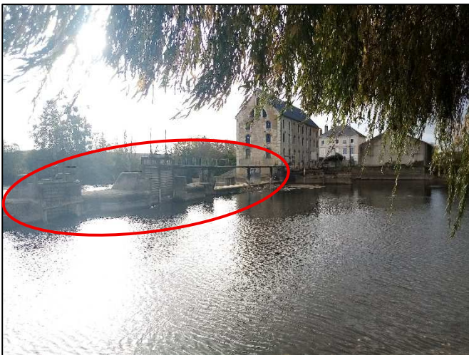
Photo 9 : Vue des ouvrages de décharge existants
