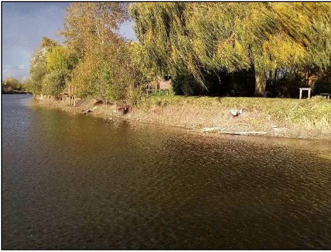
Photo 3 : Berge rive gauche en amont du barrage
