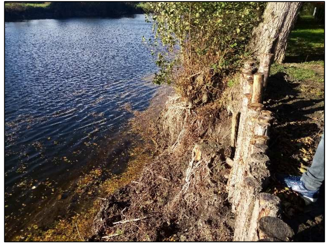
Photo 4 : Berge d'eau rive gauche, absence de rejet
