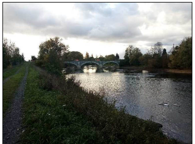
Photo 8 : Berge rive droite en amont du pont
