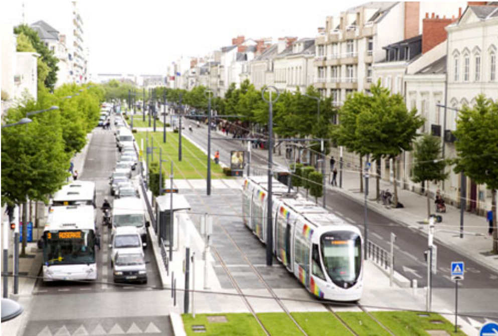
Avenue Foch à Angers 2x1 voie – 17 000 véh/j
