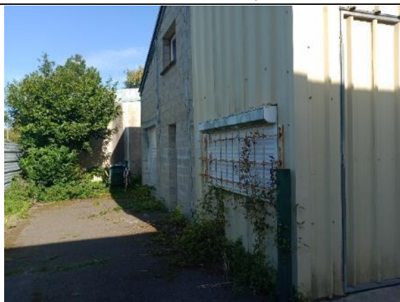
Parcelle 26 – Vue de l'ancien atelier
