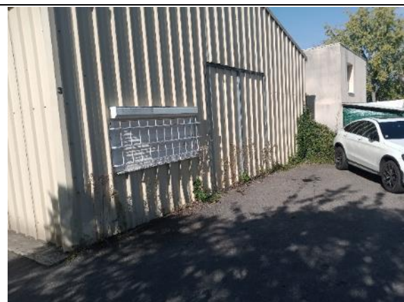
Parcelle 26 – Vue de l'ancien atelier
