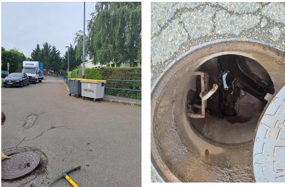
Figure 30 : Regard n°7 - réseau EP Est
