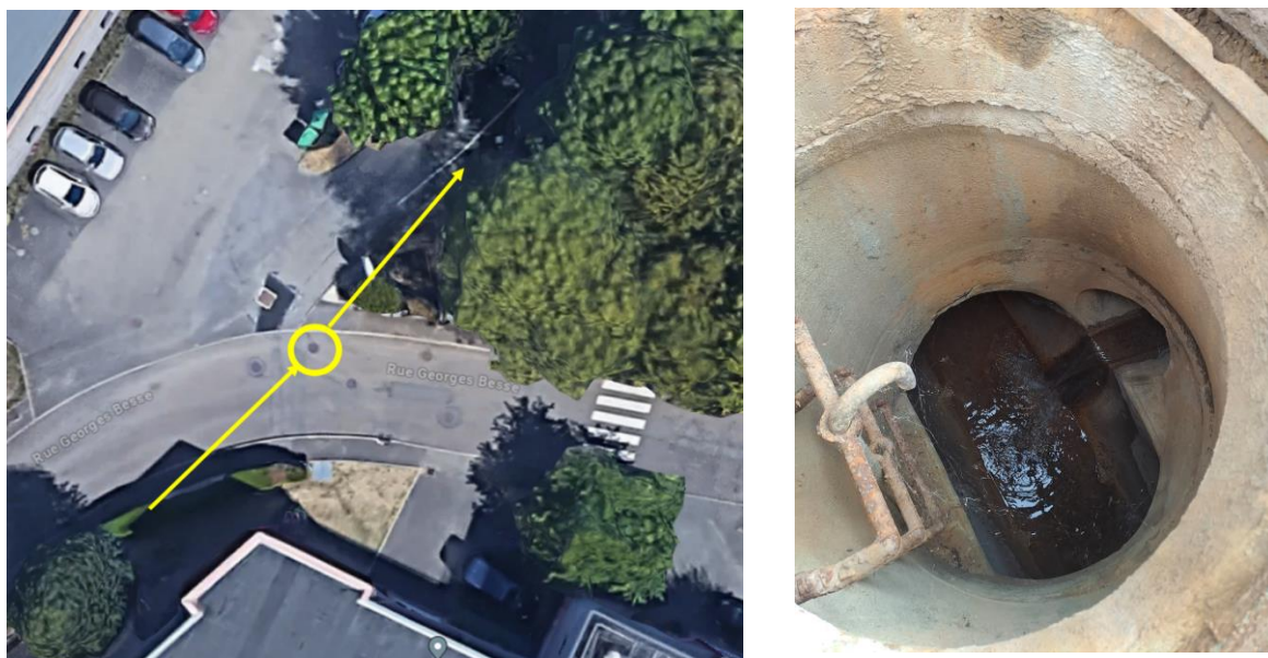
Figure 28 : Regard n°1 - réseau EP Sud
