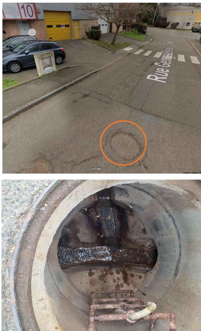
Figure 32 : Regard n°5 - réseau EP Est
