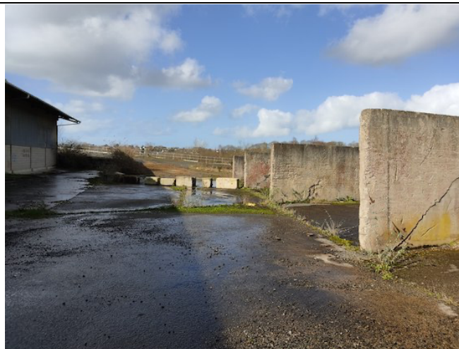
Racks de stockages au Nord-Est du site
