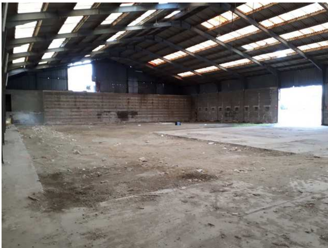
16/12/2019 – « Zone hydrocarbures » –Avant travaux, vue d'ensemble depuis le N
