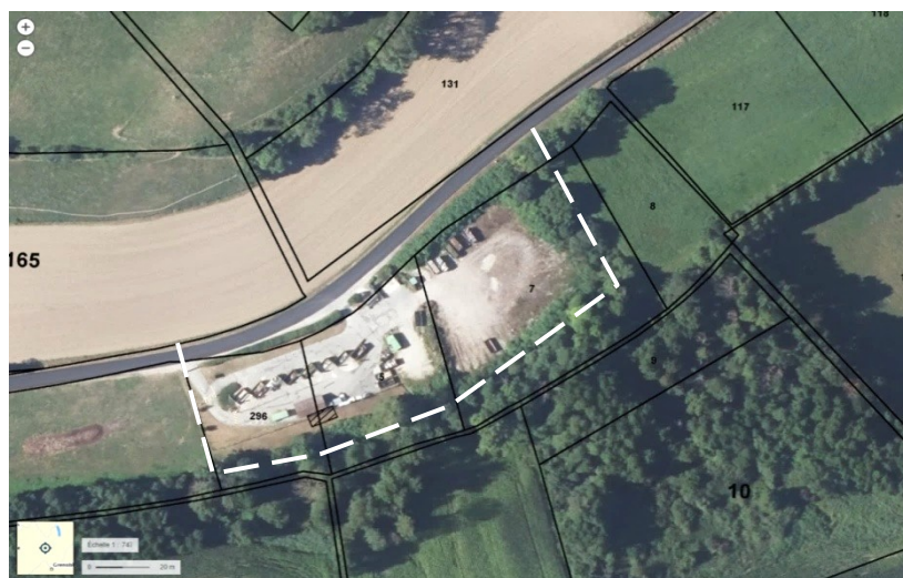
Photoaérienne du site de la déchetterie
