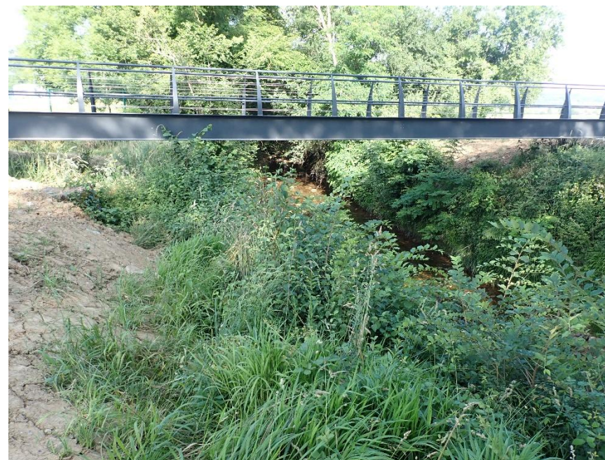
Passerelle sur l'Arrêt – 13 juin 2025
