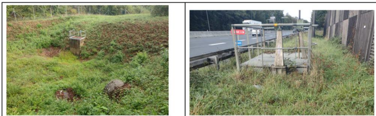
Figure 48 : Photos du bassin routier n°11B3445
