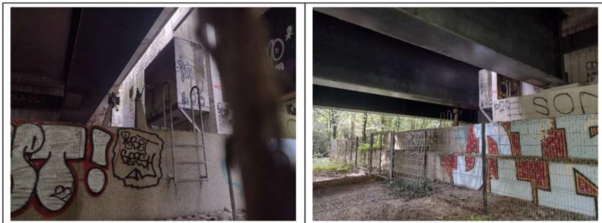
Figure 46 : Photos de la station de traitement située sous la culée ouest du viaduc de l'Erdre
