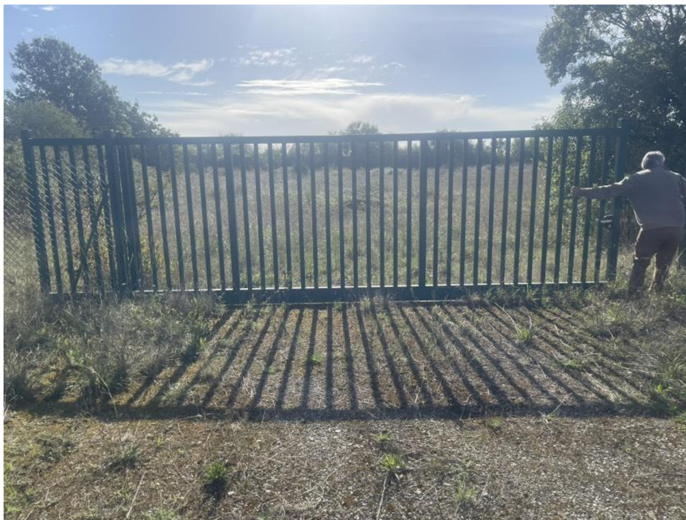
Vue 1 – Vue lointaine (septembre 2025)
