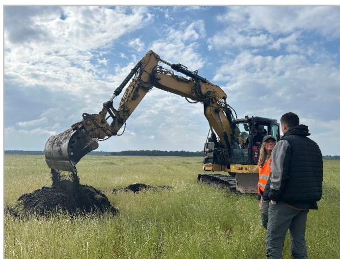
Photo 1 : Réalisation de fosse pédologique. Photo prise sur site, © Rainette, 2025
