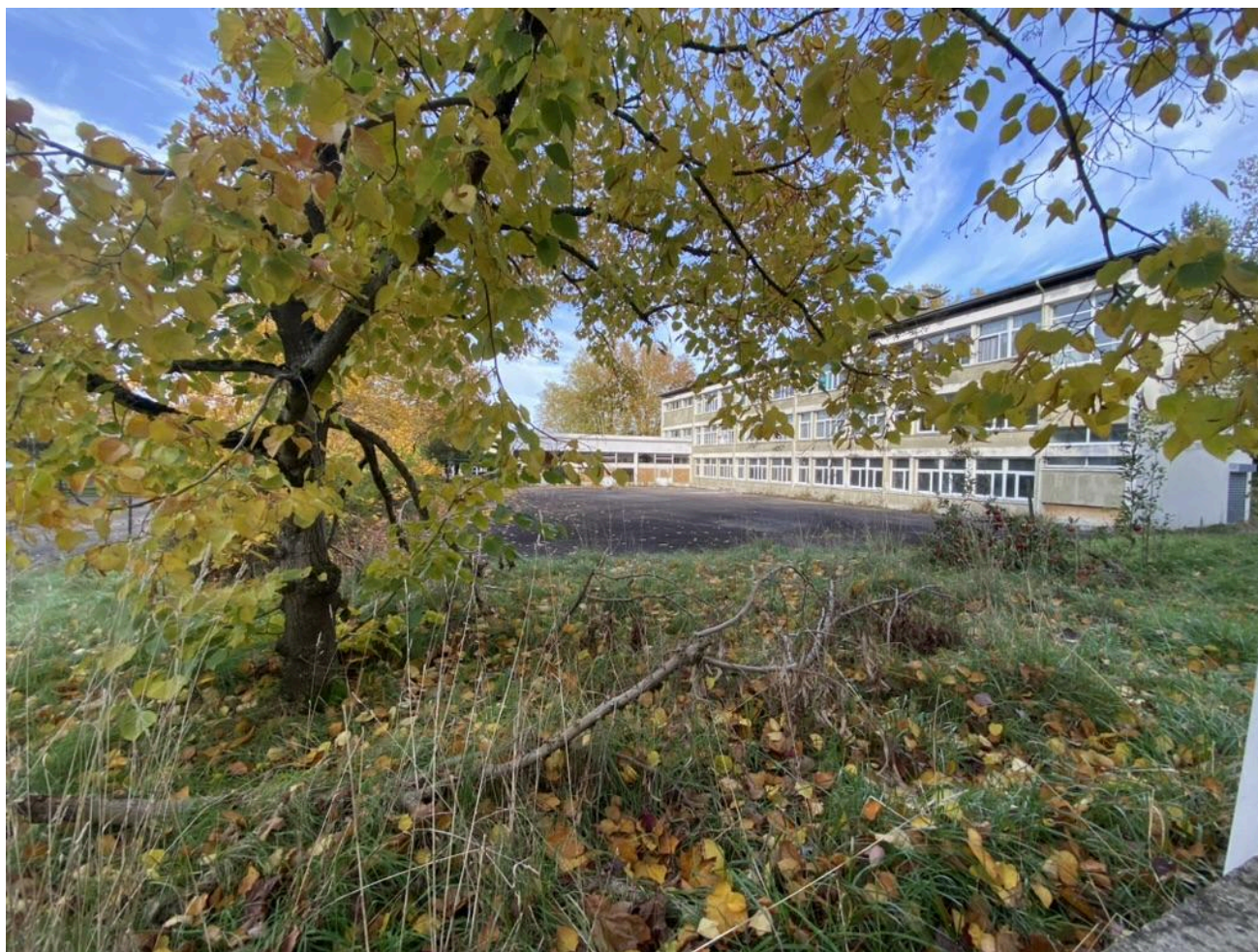
Photo N°14 – Vue intérieure de la parcelle
