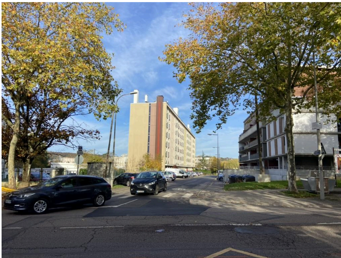
Photo N°5 – Vue du site vers la rue des Poilus d'Orient
