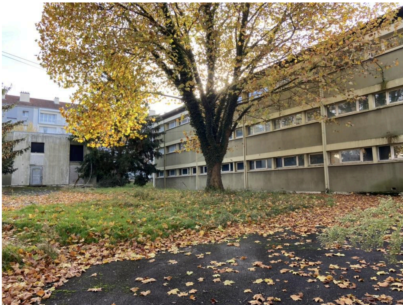
Photo N°4 – Perspective rue de Brabois vers l'intérieur du site
