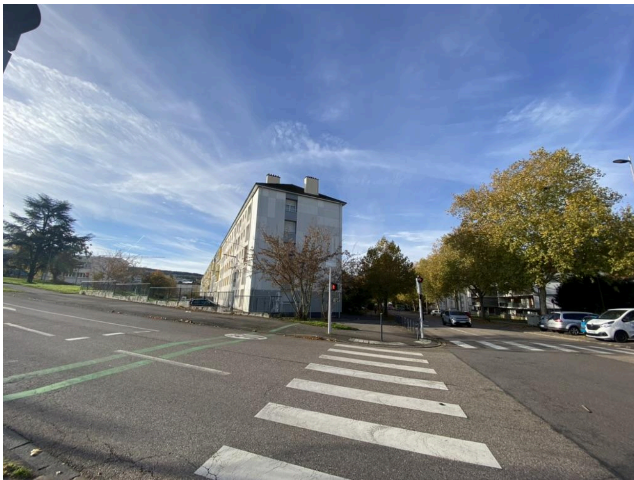
Photo N°2 – Vue du site depuis l'avenue de Brabois
