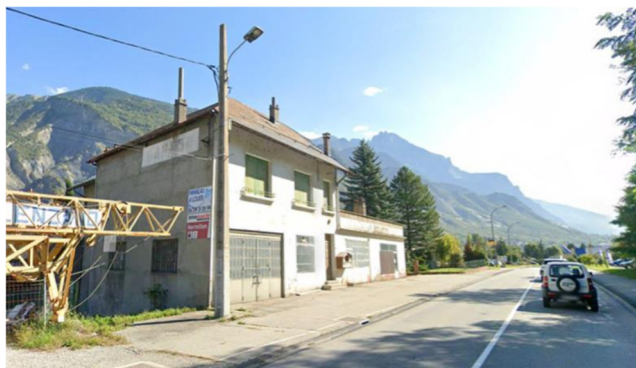
Vue au sol - septembre 2024 1
