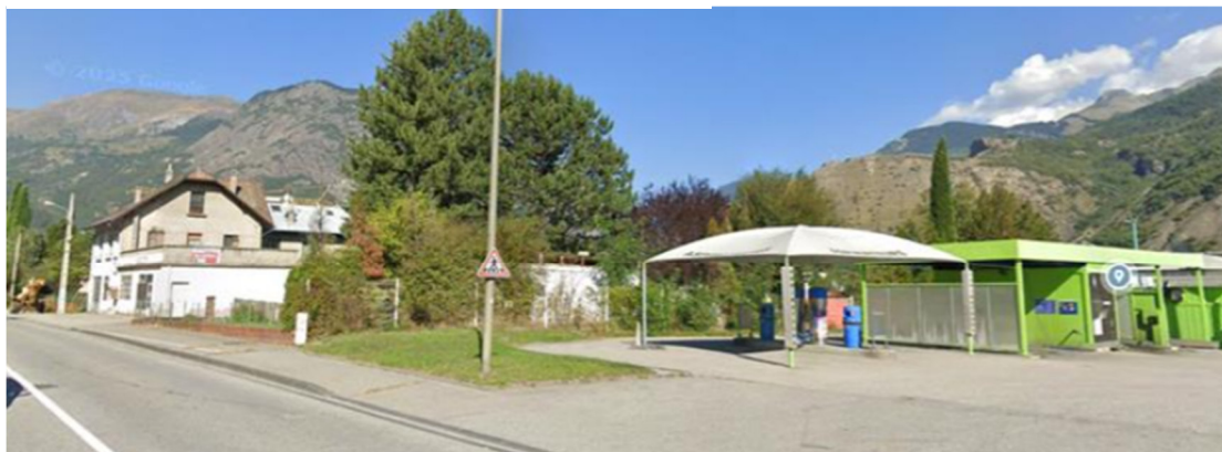
Vue au sol - septembre 2024 2
