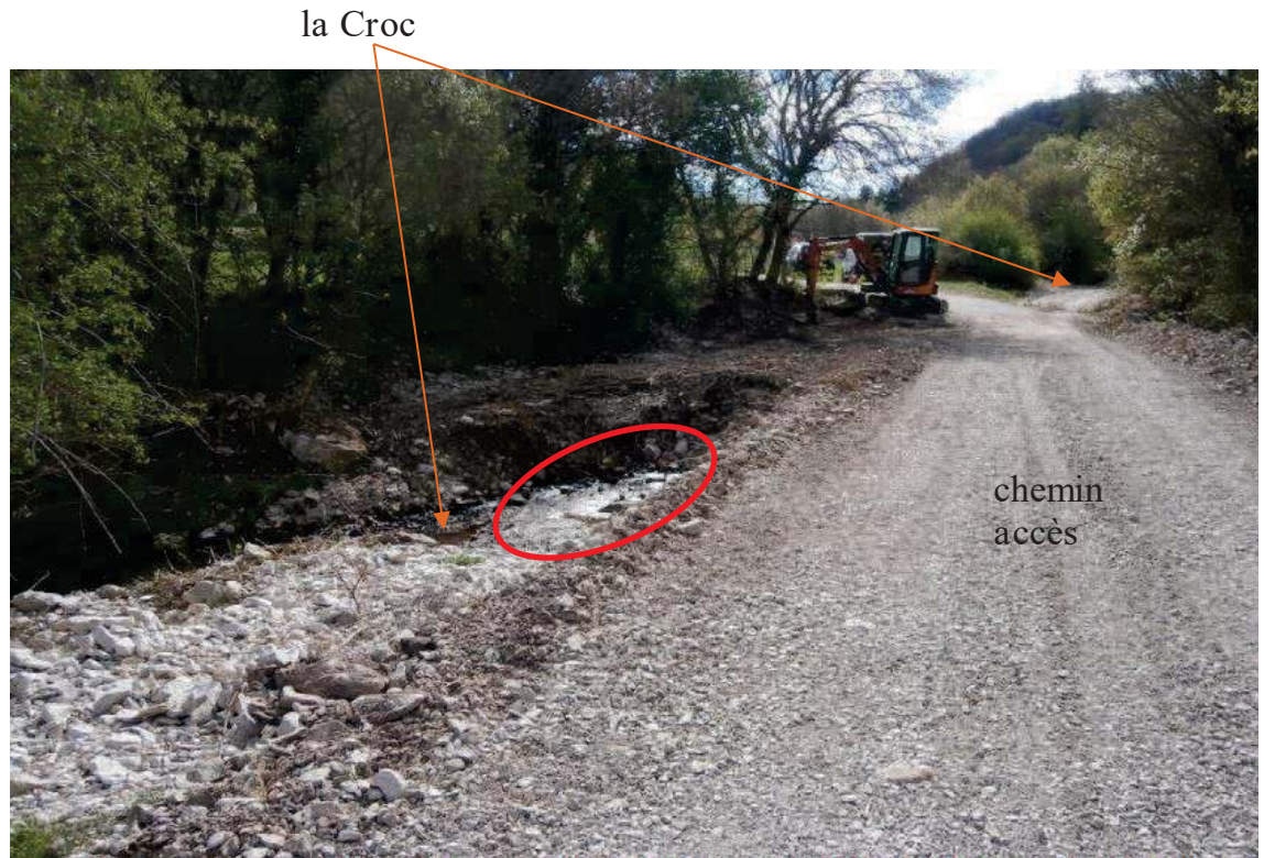
Illustration n° 8 : vue du lit de la Croc et du chemin d'accès en aval de la station d'épuration, zone de rejet des eaux de la station entourée en rouge
