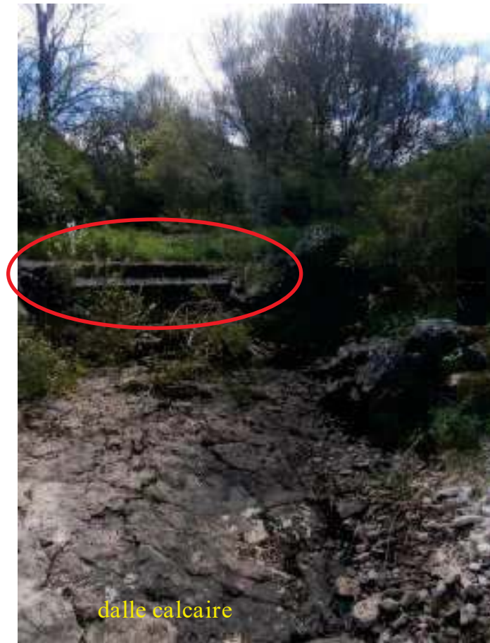
Illustration n° 15 : vue vers le SE du lit de la Croc à une centaine de mètres de la station d'épuration, seuil entouré en rouge
