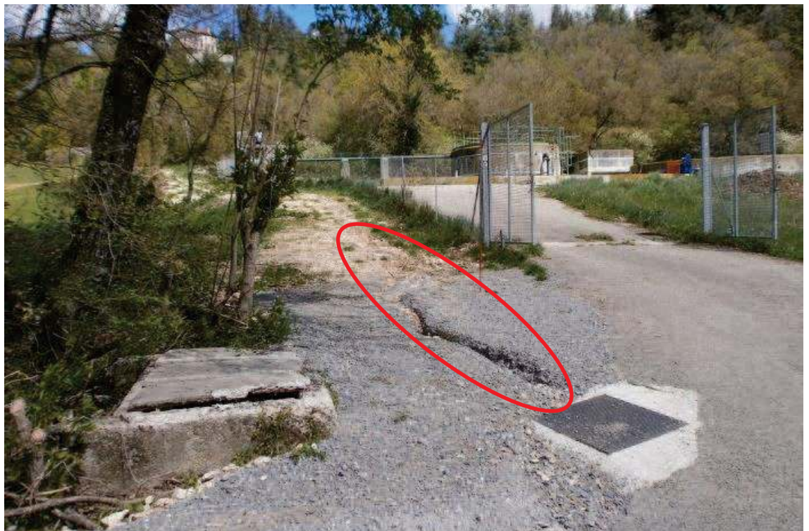
Illustration n° 11 : vue vers le N du chemin situé à l'W de la station d'épuration, rigole de ruissellement entourée en rouge
