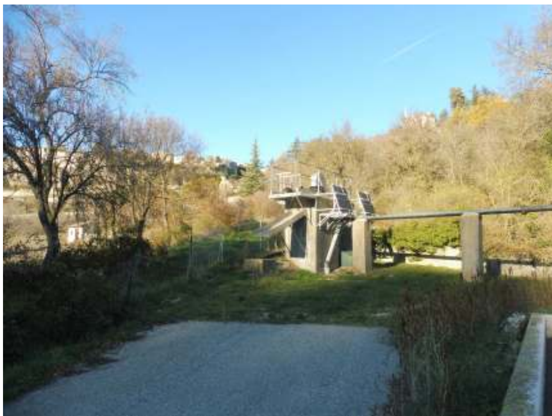
VUE DE LA STATION D'EPURATION VERS LA VILLE DE SAULT
