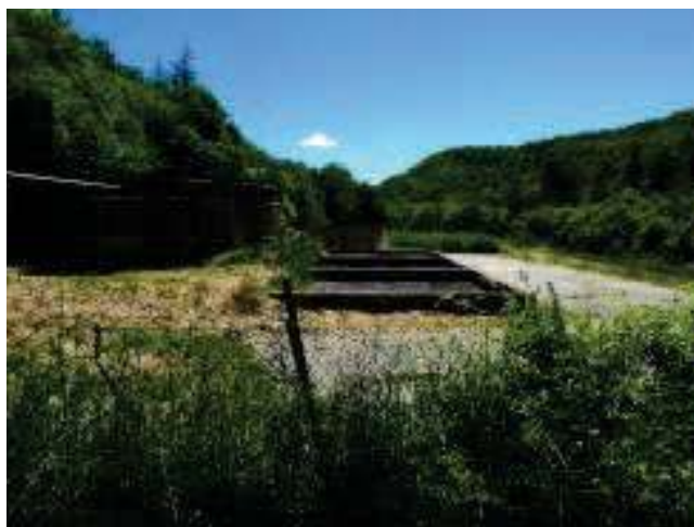
La STEP et ses dépendances attirent peu les oiseaux si ce ne sont quelques Bergeronnettes grises qui viennent chasser des insectes sur les pelouses fauchées ou sur les bacs de décantation. Photo prise dans la zone d'étude – ECOTER, 2025
