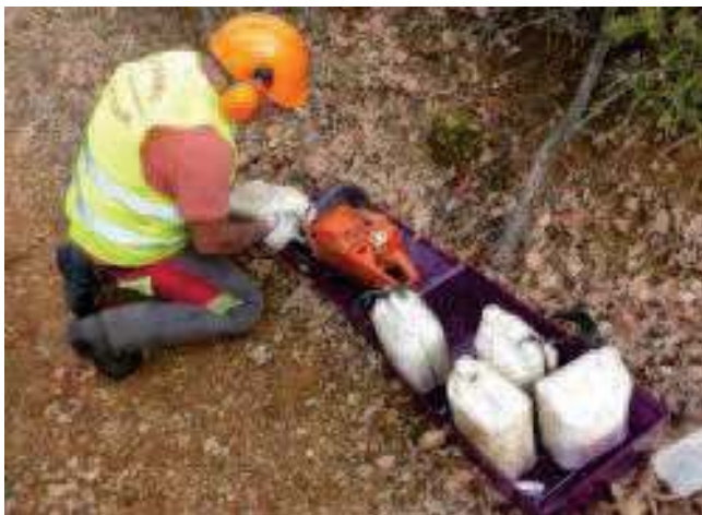
Tous les contenants de produits polluants doivent être placés sur des bacs de rétention ou sur une plateforme étanche adaptée. © DRYOPTERIS
