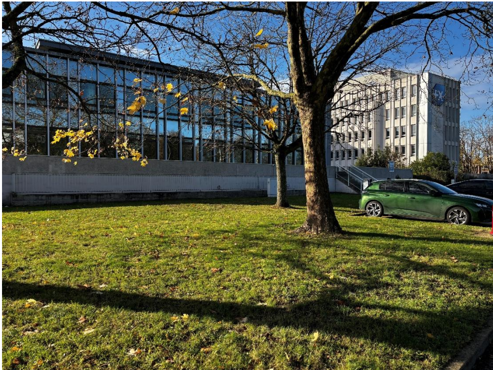
Vue sur le bâtiment principal depuis le nord du site – Visite de terrain TERA0 11/2025
