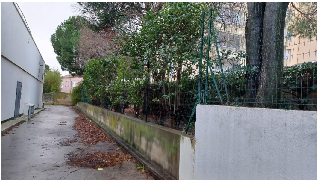
Photo 5 : Clôture présente dans le secteur d'étude (Citadia, novembre 2025)
