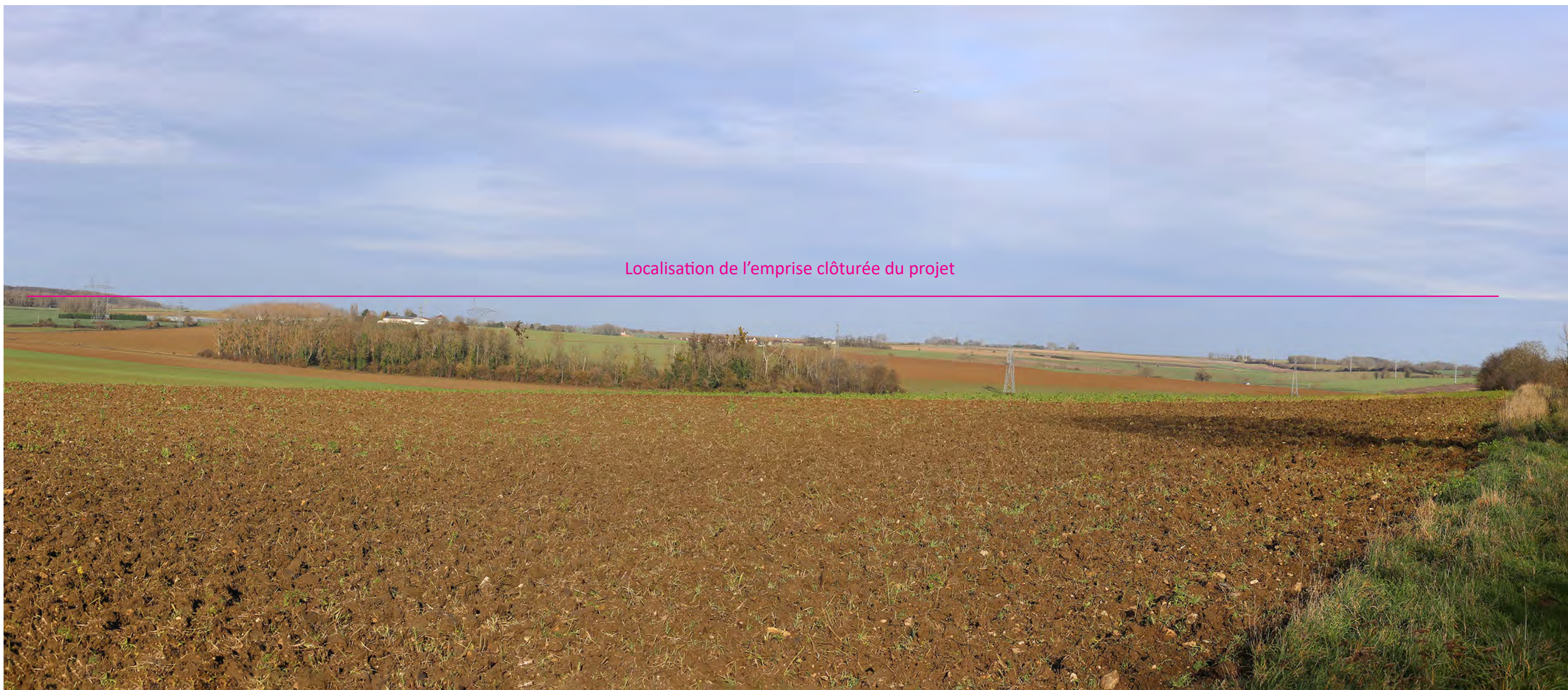
Point de vue n°1 - Vue initiale entière sur la centrale stockage batteries + poste HTB depuis le sud du projet
