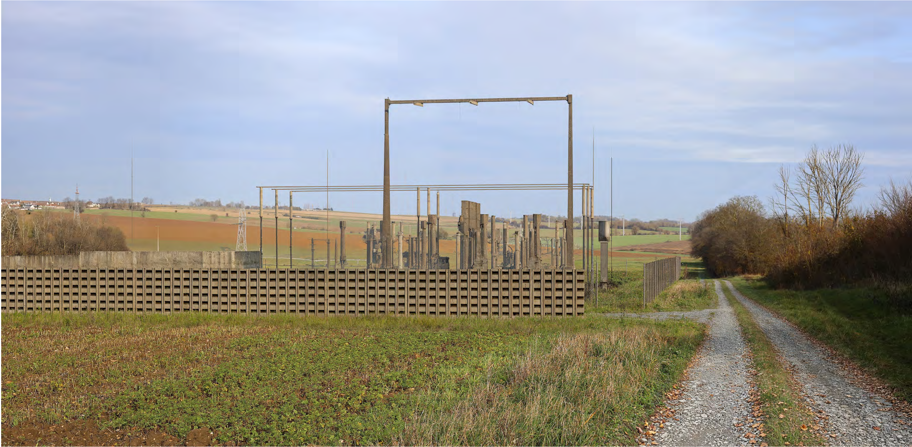
Point de vue n°2 - Vue centrée sur le poste HTB depuis le sud du projet - sans mesures paysagères.
