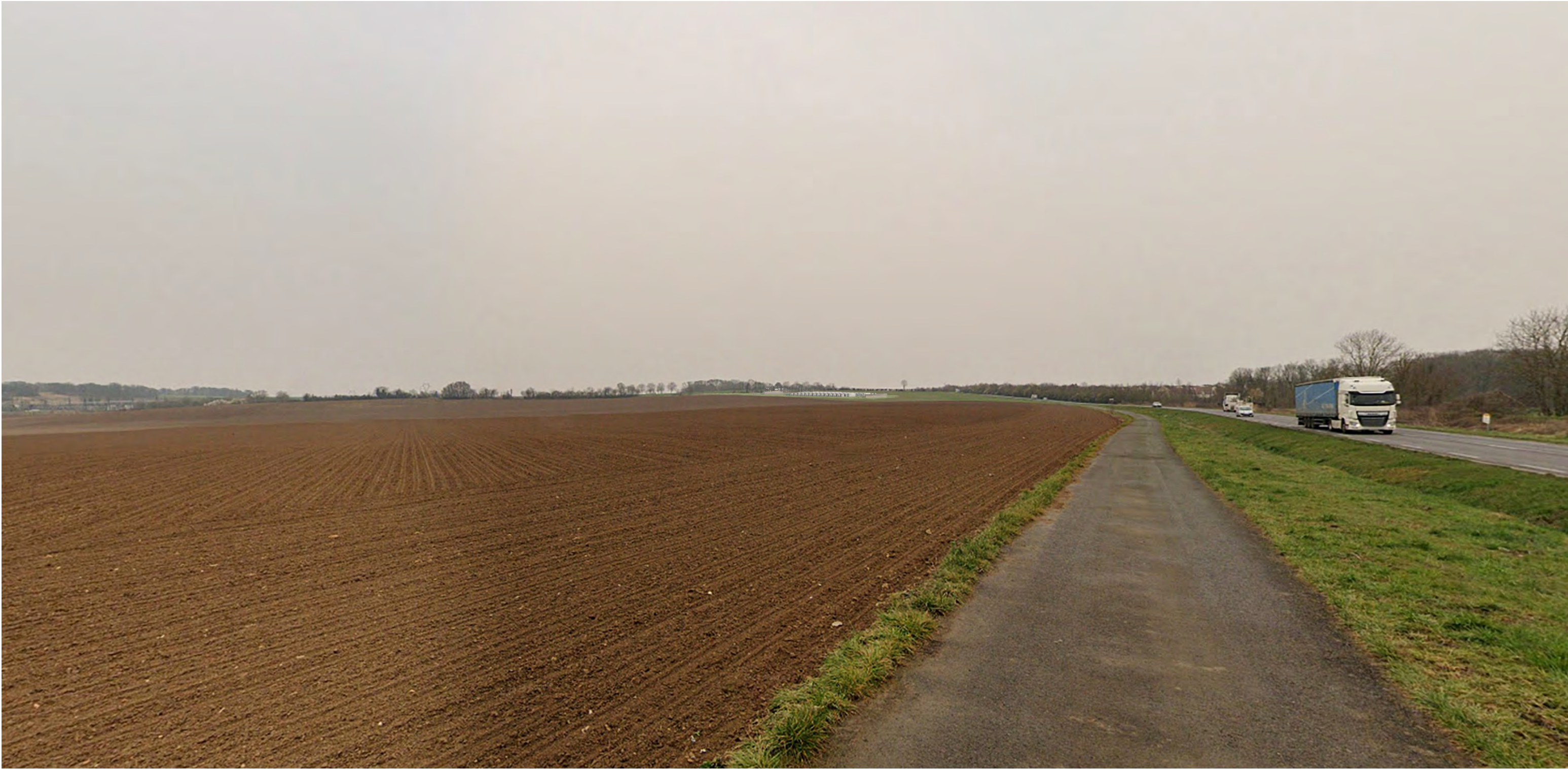
Point de vue n°3 - Vue depuis la departementale n°405 au nord ouest du projet - sans mesures payasgères
