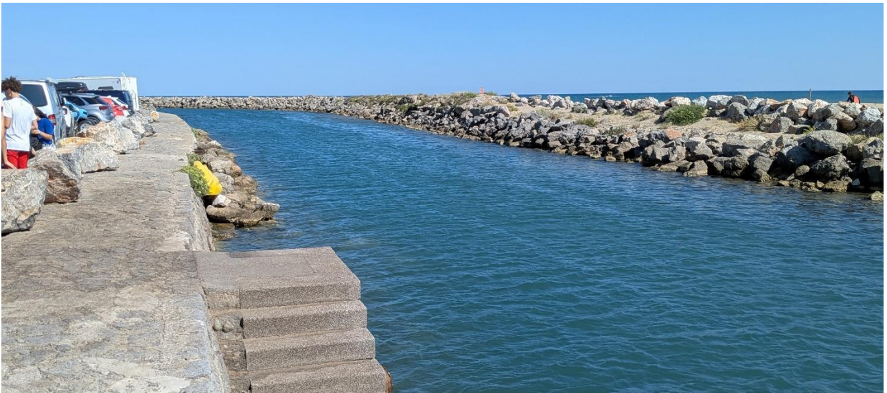
Photo 2 : Vue du canal du Grazel en amont de la passe (CISMA Environnement, juillet 2025)
